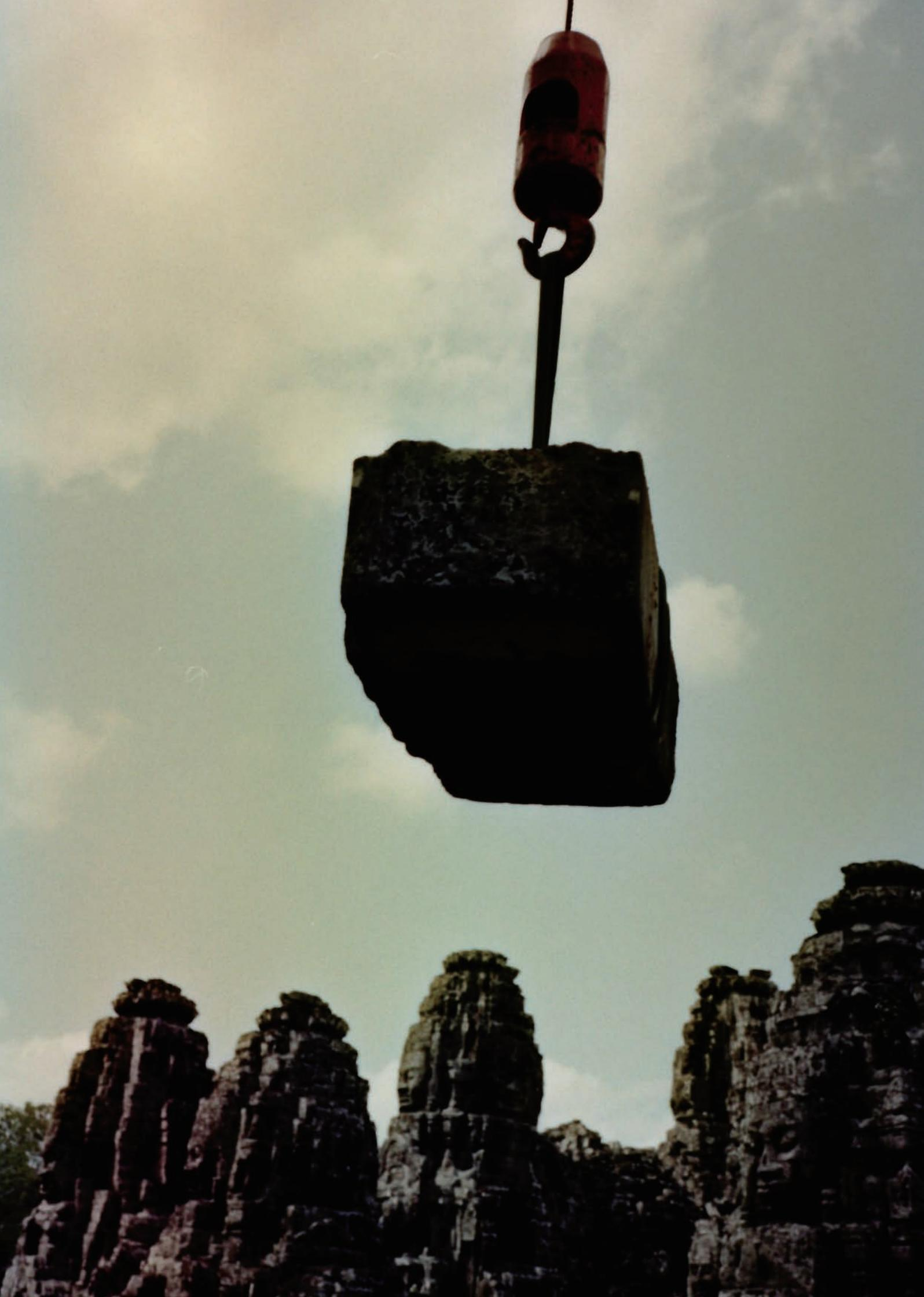
1996年7月のバイヨン北経蔵修復工事に初めてラフタークレーン(25t)を導入。カンボジア人オペレーターの訓練を始めた。オペレーター候補生たちは、日本人専門家の腕に対して、一せいに驚きの声を発していた。
